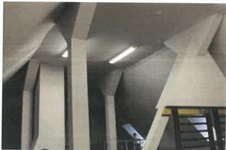
Fot.7 Zabudowa konstrukcji dachu oraz poddasza od palnej konstrukcji dachu.
