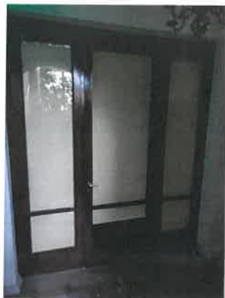
Fot.11. Bezklasowe drzwi oraz bezklasowa ściana pokoju tarasowego
