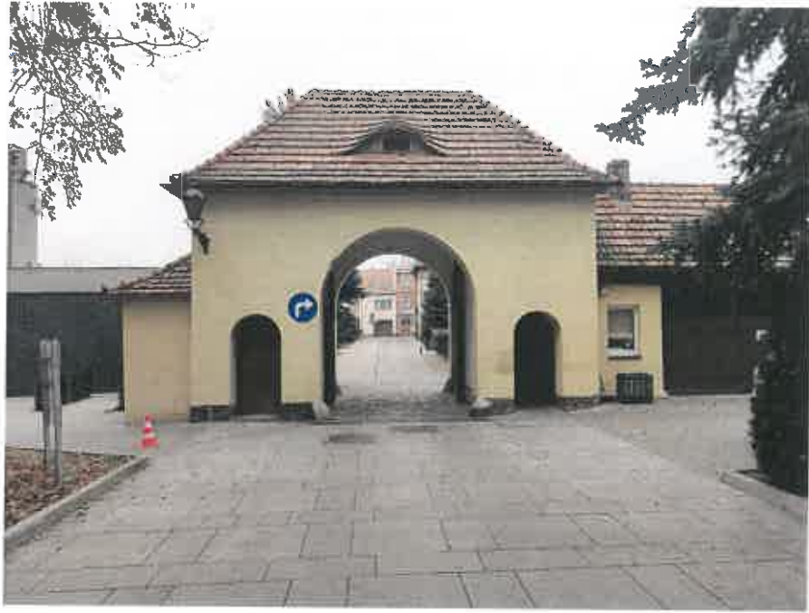
Fot.20. Wjazd na teren centrum posiadający odstępstwo WKW.
