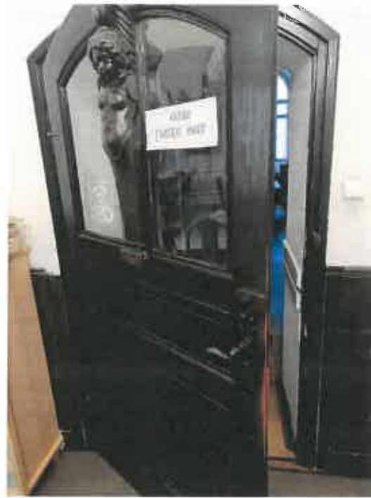
Fot. 15. Drzwi ze świetlicy otwierające się do środka
