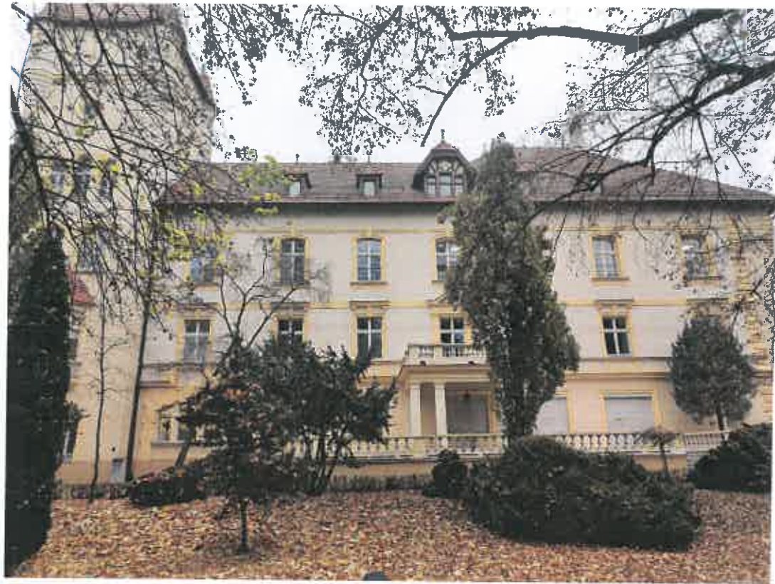
Fot.1 Widok od strony południowej
