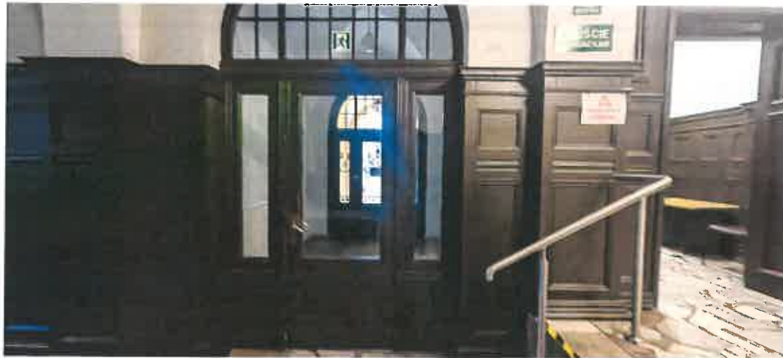
Fot. 16 Drewniane boazerie przy wyjściu głównym oraz przy wyjściu z windy. Obudowa drogi ewakuacyjnej wykonana jako bezklasowe naświetla przy drzwiach
