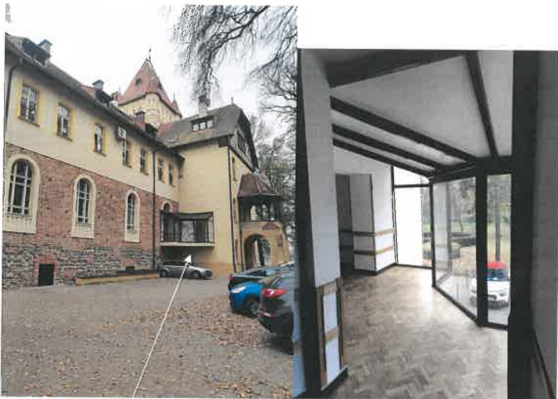
Fot.4 i 5 Ściana zewnętrzna z płyt poliwęglanowych widok od zewnątrz i od wewnątrz
