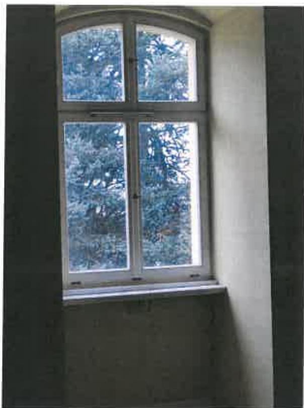
Fot. 18. Oddymianie klatki schodowej KS2
