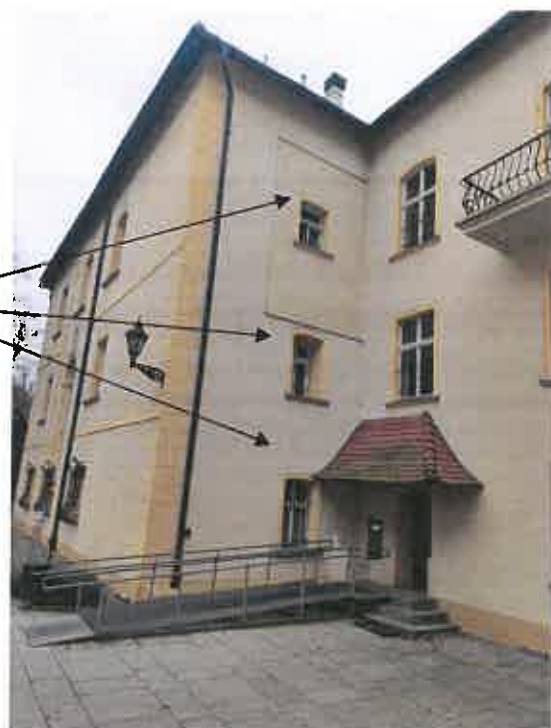
Fot.6 Bezklasowe okna w ścianie oddzielenia przeciwpożarowego
