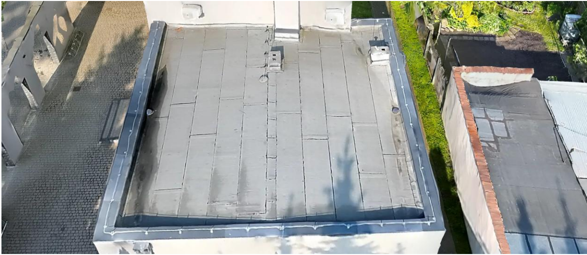
Rys. 3 Dach nr 1 budynku Centrum Rehabilitacji
