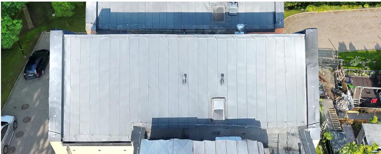
Rys. 5 Dach nr 3 budynku Centrum Rehabilitacji
