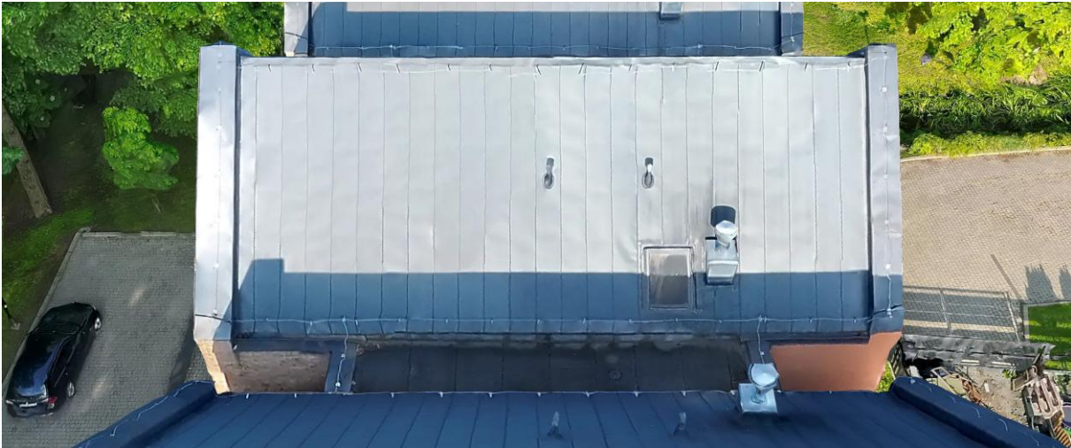
Rys. 7 Dach nr 5 budynku Centrum Rehabilitacji
