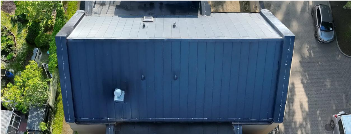
Rys. 6 Dach nr 4 budynku Centrum Rehabilitacji
