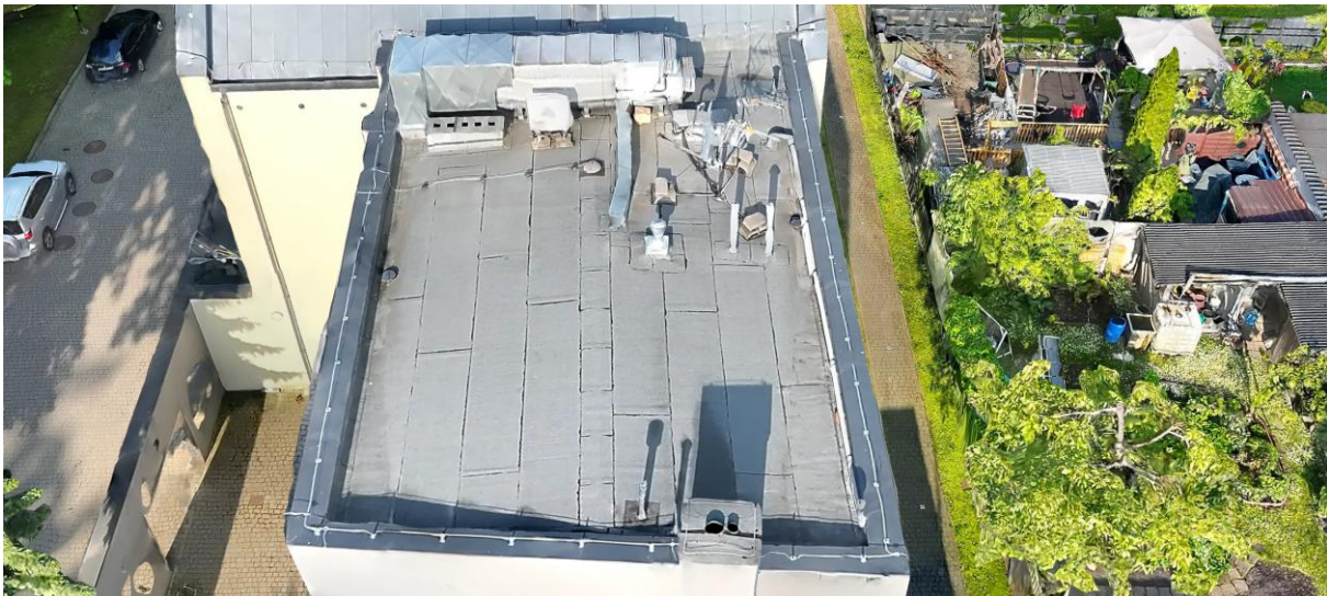
Rys. 4 Dach nr 2 budynku Centrum Rehabilitacji
